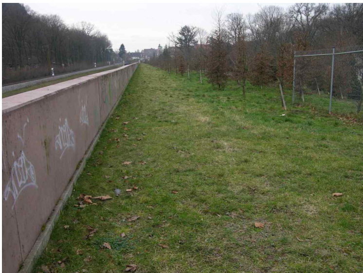
Lärmschutzgalerie West 2008 ??? Freiburg Solar B31 II 200 kWp → ca. 20.000 kWh/a
